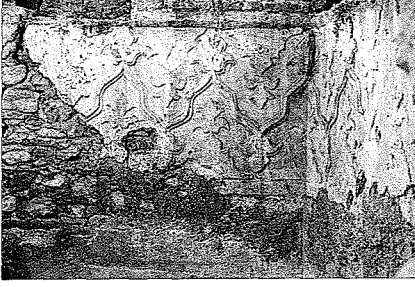
İsmâil Bey Hamamı'nın duvarlarındaki alçı süsleme
